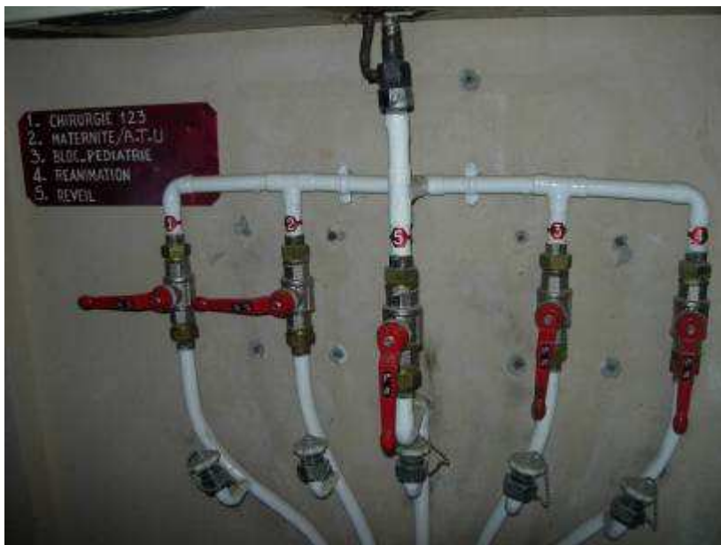
3 circuits sur 5 fonctionnent avec une pression de 4 bars
